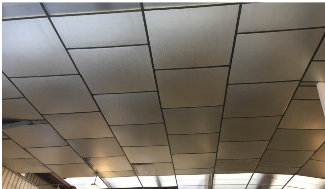
Instalación del nuevo aislamiento en el techo de la nave
