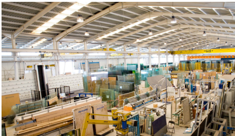
Planta, con las nuevas luminarias instaladas
